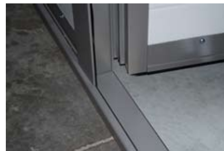
faible hauteur de seuil
